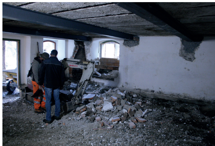
I primi scavi per abbassare il pavimento. Erste Grabung, um den Boden abzusenken.
